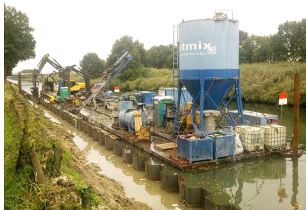
3.5 Aanbrengen ankers vanaf het water
