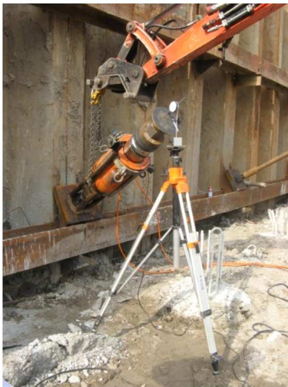
4.1 Testopstelling vóór damwand
