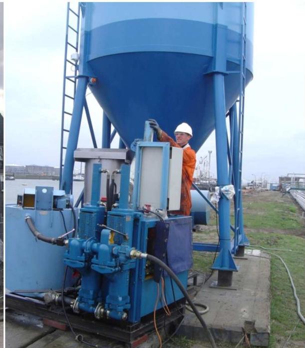
3.2 Groutmenginstallatie met cementsilo
