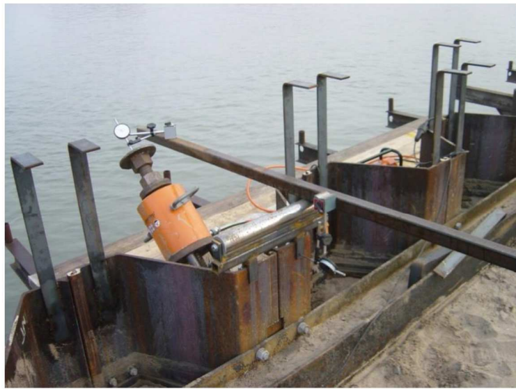
4.2 Testopstelling over kop damwand
