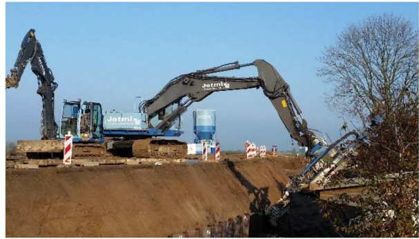
3.7 Aanbrengen ankers "over de kop"
