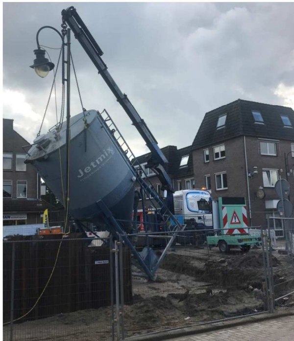
3.1 Aanvoer en plaatsen cementsilo
