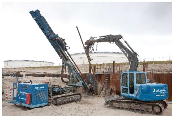
3.6 Aanbrengen ankers vanaf het land
